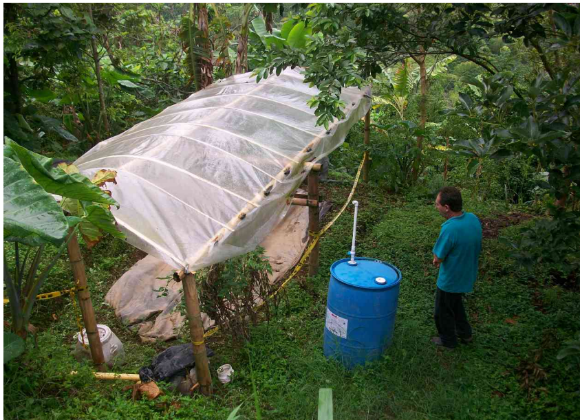
Biodigestor en El Cábulo , Don Víctor Gómez 2
