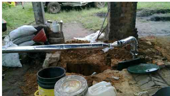
Caldera de Ecoenergy
